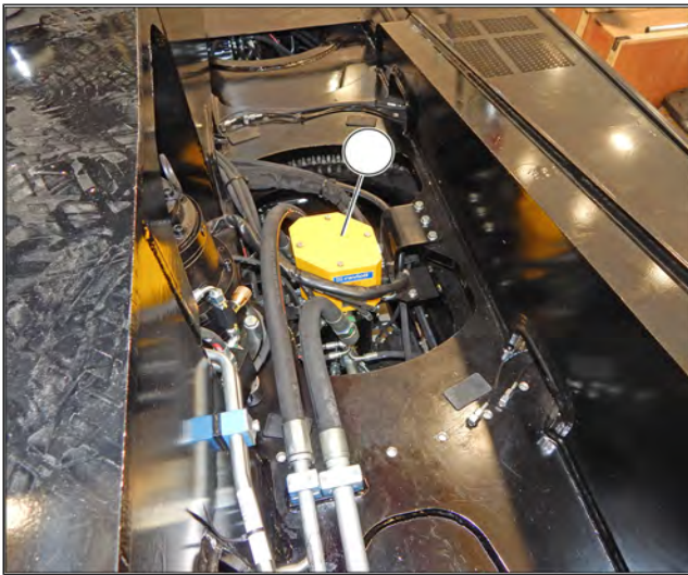
Figure 307: Vérification et nettoyage des bagues émettrices du collecteur électrique rotatif
